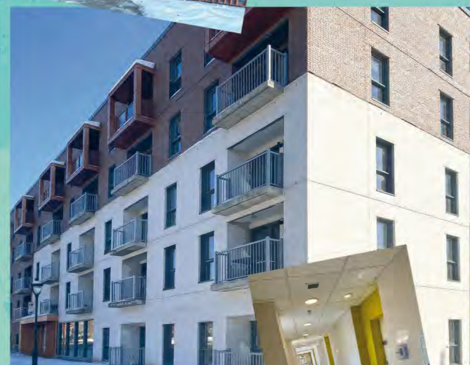
Les Habitations de la Fondation des Aveugles du Québec - Projet Les Habitations de la FAQ - Sherbrooke
